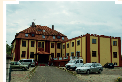
Adam Roman Gumny "ADAMPOL" Pałac nad Jeziorem w Chociwlu: „Rozbudowa bazy hotelowej poprzez budowę nowych pokoi noclegowych i ich wyposażenie"
